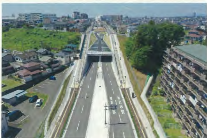
宮沢根白石線（浦田工区） 令和元年6月開通
