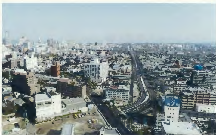
宮沢根白石線外1線（南鍛冶町～舟丁工区） 令和5年3月開通
